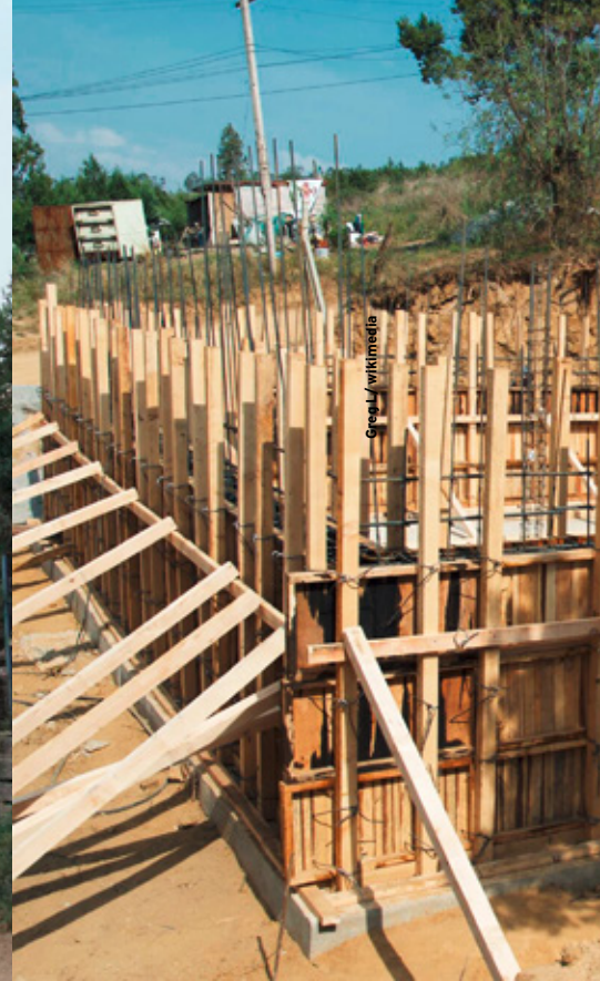
Bau des Wasserreservoirs.
