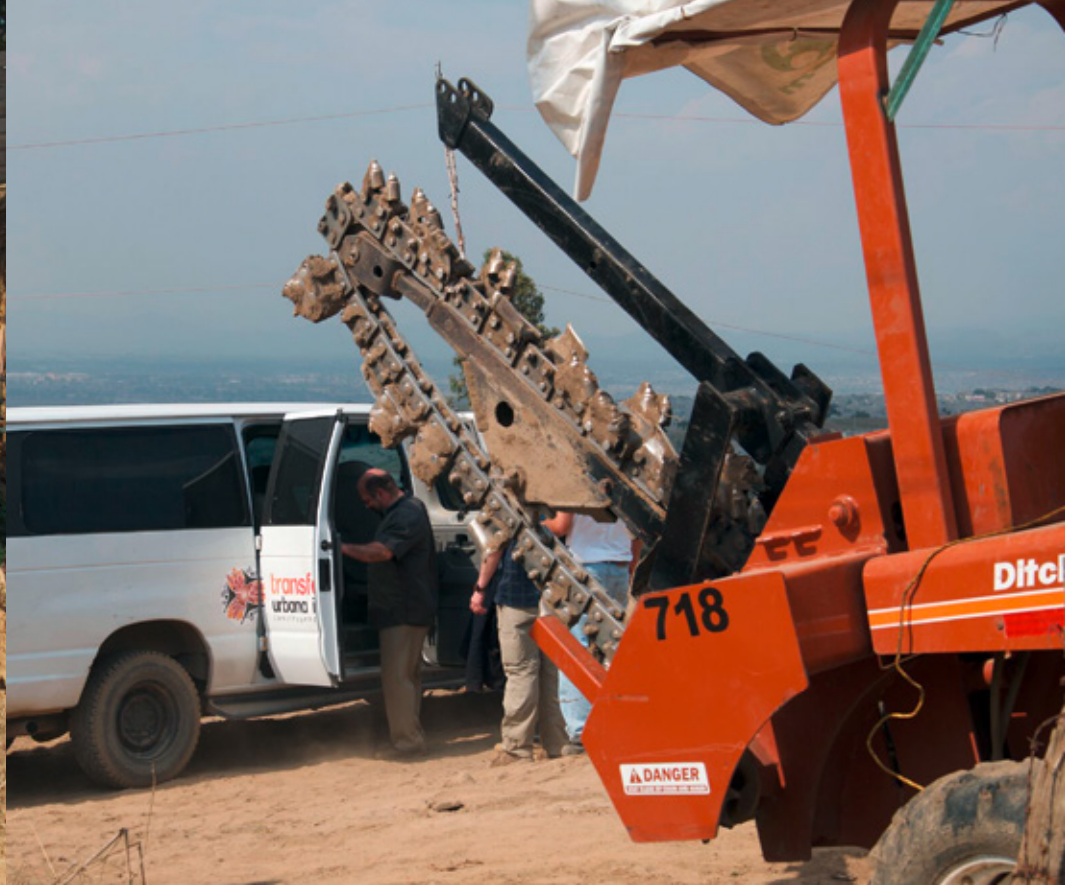
Auf diesem Hügel wurde das Wasserreservoir gebaut.
