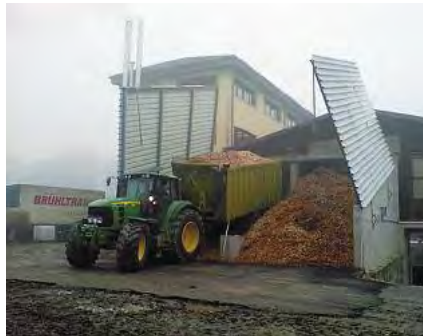
Holzschnitzelheizung in Hedingen ZH
